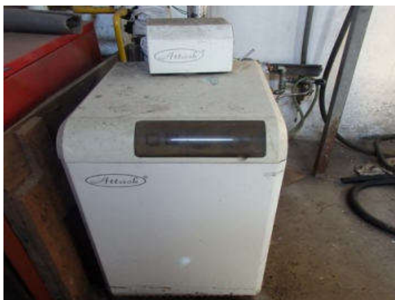
Obrázok 4: Plynová kotolňa a príprava teplej vody
